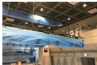
小ホール改修
